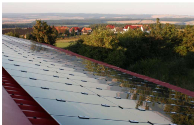
Solarpark Sachsen Sonne – Bildquelle: Green City Energy AG
